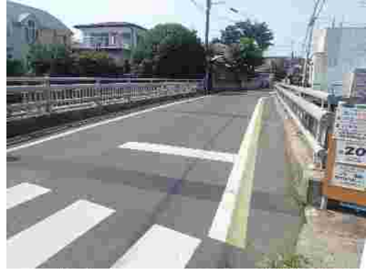
図 1 0 R3 橋面補修工
