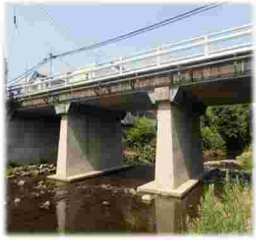
松戸橋洗堀防止工
