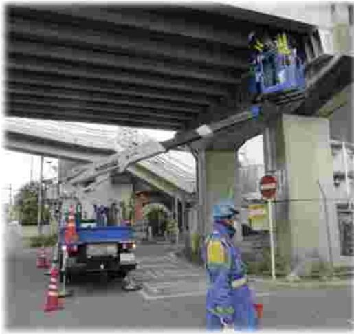
所沢陸橋点検状況
