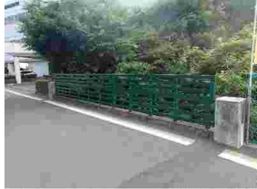
図 1 2 H31 橋面補修工、防護柵塗替え工
