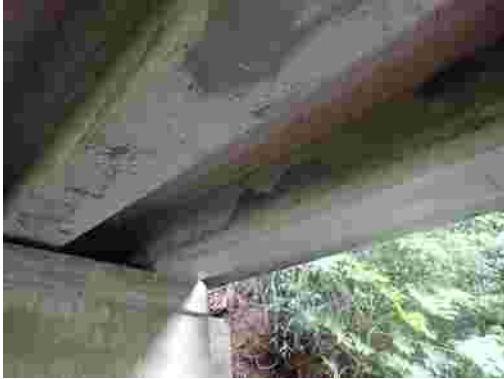
図 1 1 H31 断面修復工
