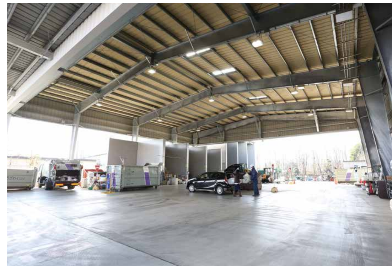
受入ステージ棟(内部)
