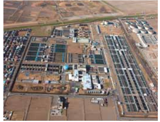
埼玉県大久保浄水場 (写真：埼玉県企業局提供)
