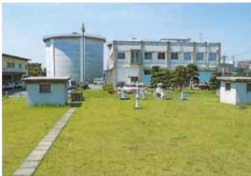
第一浄水場 宮本町二丁目7番7号
