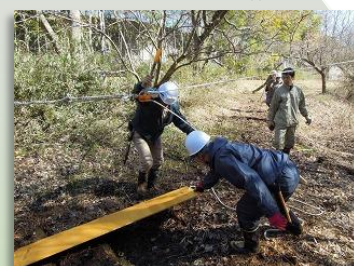
湿地では足場の確保に一苦労です
