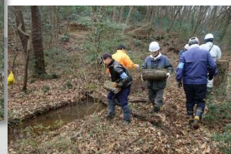
足場が悪く、搬出作業も一苦労でした。
