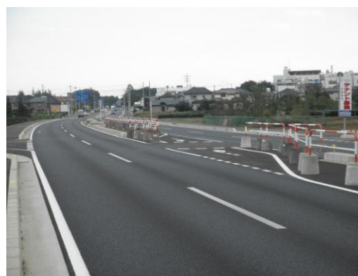
都市計画道路 東京狭山線の整備
