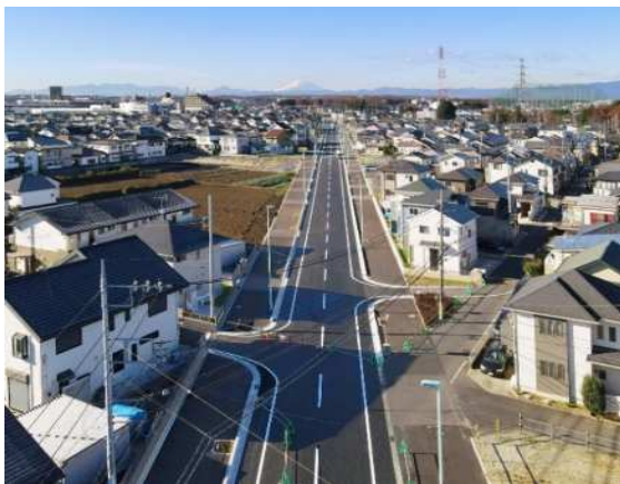
北野下富線(3工区開通)
