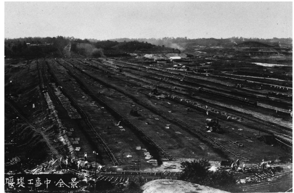
写真 1-27 山口貯水池建設
