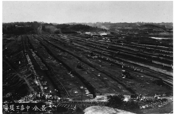
写真 1-27 山口貯水池建設
