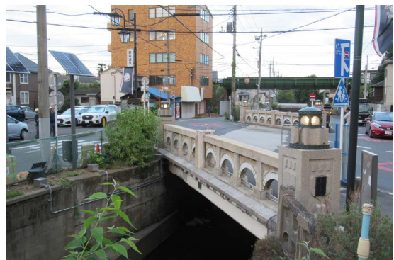
写真 2-5 旭橋（令和 7 年に電灯を復元）
