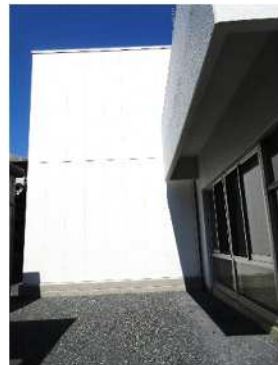
外から見るエレベーター棟
