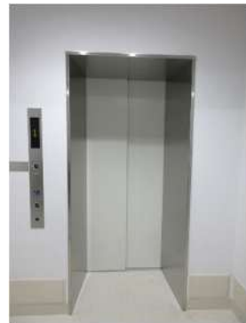
1階乗降スペースからの エレベーター外観
