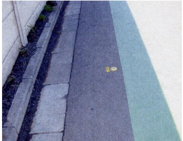
舗装面に設置されていることが多い
