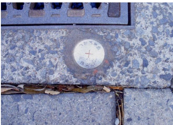
雨水枡の枠に設置
