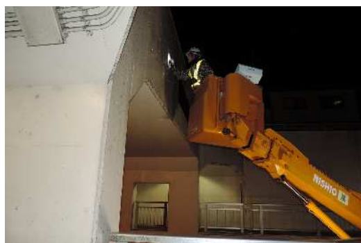
図8 橋梁の定期点検の実施状況
