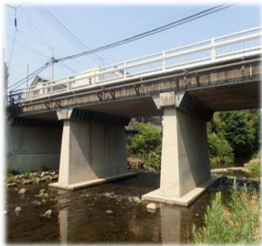
松戸橋洗堀防止工
