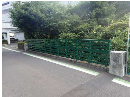
図 1 2 H31 橋面補修工、防護柵塗替え工
