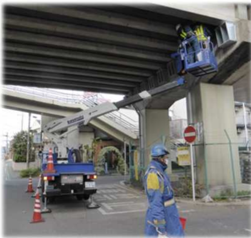
所沢陸橋点検状況
