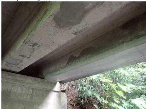
図 1 1 H31 断面修復工
