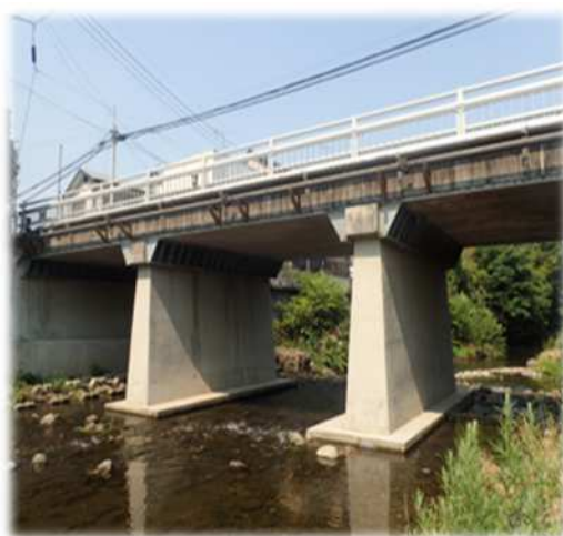
松戸橋洗堀防止工
