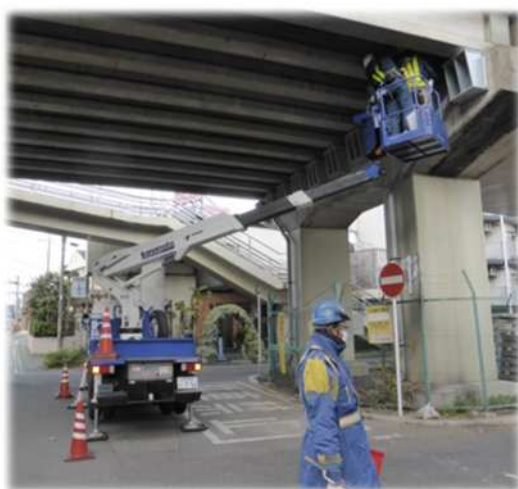
所沢陸橋点検状況
