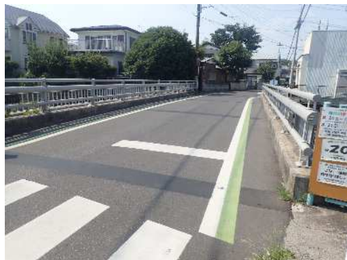
図10 R3 橋面補修工
