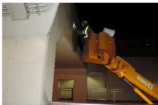
図8 橋梁の定期点検の実施状況
