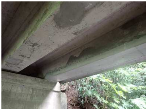
図11 H31 断面修復工
