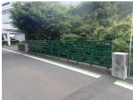
図12 H31 橋面補修工、防護柵塗替え工
