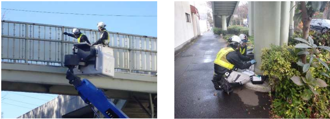
図7 橋梁の定期点検の実施状況
