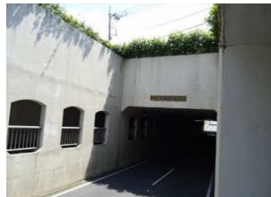
写2 - 新所沢跨道橋 供用開始後23年経過
