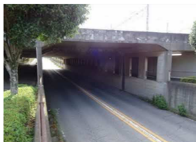
写4 - 東所沢アンダーパス 供用開始後約50年経過
