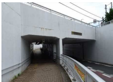
写3 - 狭山ヶ丘跨道橋 供用開始後18年経過
