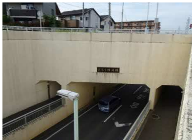
写1 - 上新井跨道橋 供用開始後21年経過
