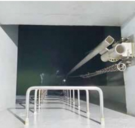
浸出水調整槽
