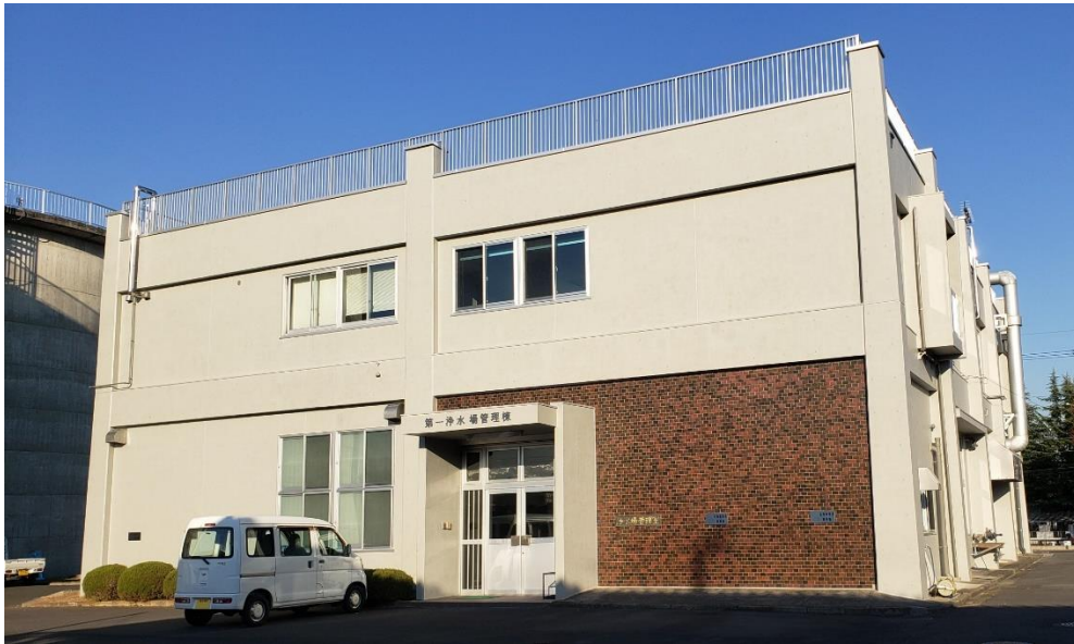
第一浄水場 管理棟
