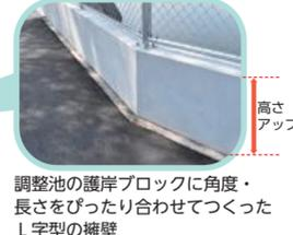
調整池の護岸ブロックに角度・長さをびったり合わせてつくったL字型の擁壁
