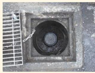
▲降った雨を集め、地下に浸透させる改良工事後の雨水ます
