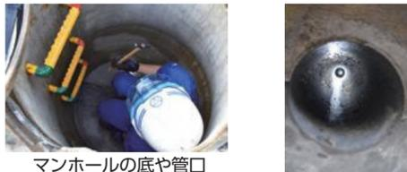
マンホールの底や管口周りをハンマーで叩き、コンクリートに隙間がないか確認
