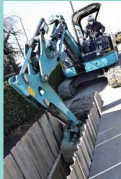
管路を設置する位置に沿って道路を掘り下げて、管を設置した後に、その上部を埋め戻し、道路復旧する工法。
