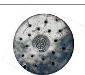
昭和34年度より設置が開始された鉄筋コンクリートの蓋。
