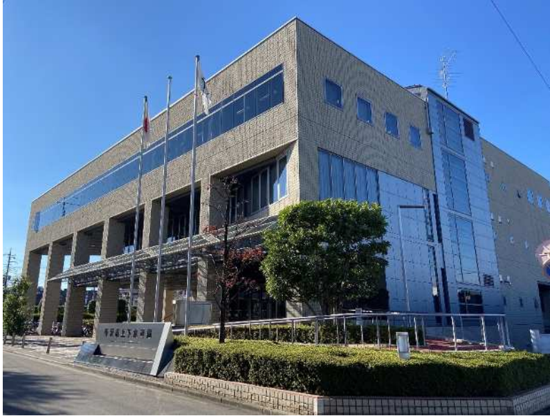
所沢市上下水道局庁舎
