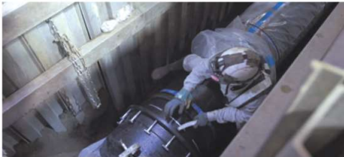
水道管の布設替えの工事の様子
