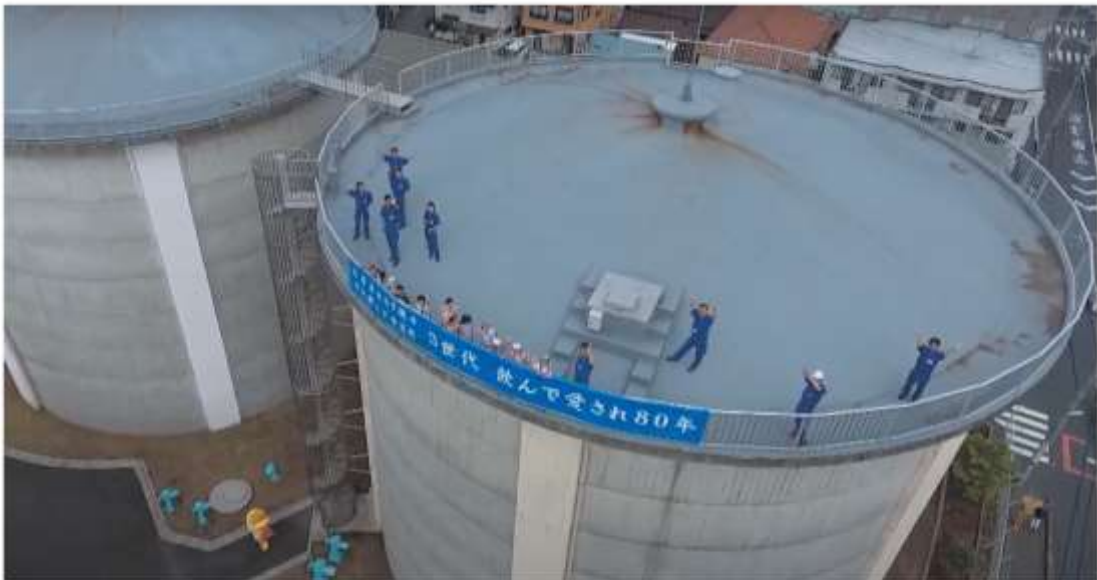
水道通水80周年記念事業における浄水場見学会の様子
