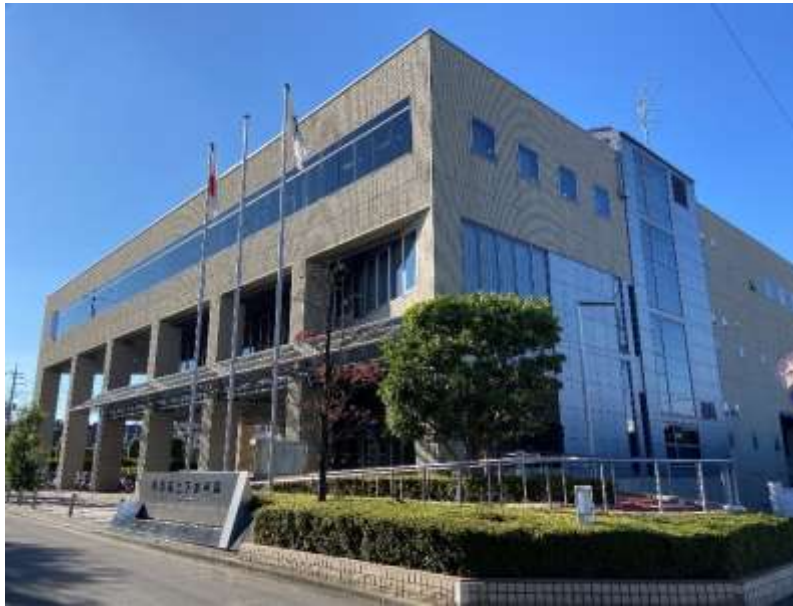
所沢市上下水道局庁舎
