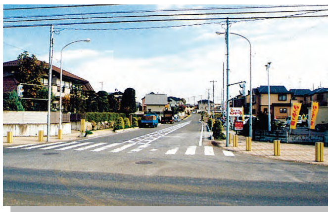
造成後の区画道路
