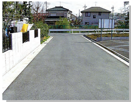
造成後の区画道路
