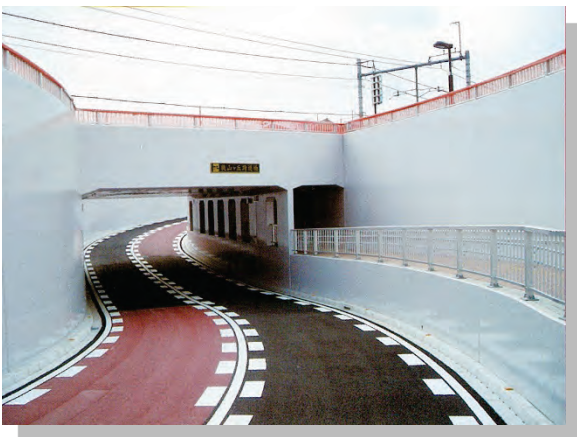
立体交差道路（アンダーパス）
