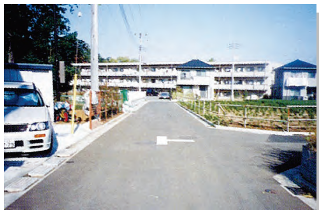
造成後の区画道路
