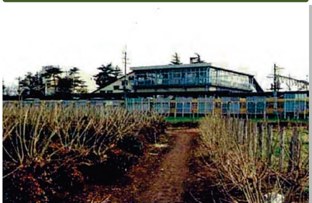
施行前 狭山ヶ丘駅東口駅前ロータリー
