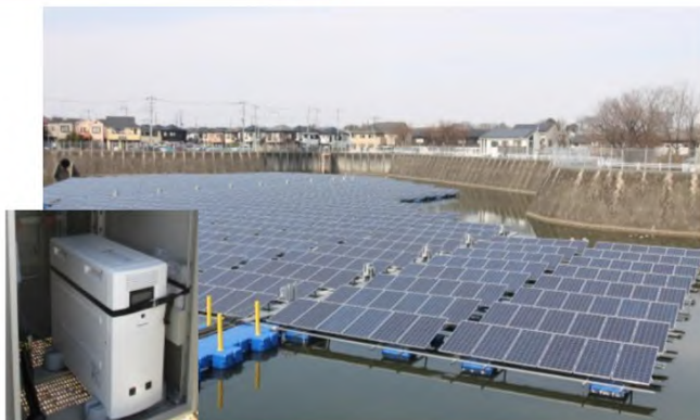
フロートソーラー所沢は可搬式蓄電池 2 基を設置する太陽光発電を活用した防災モデルとなっています。
