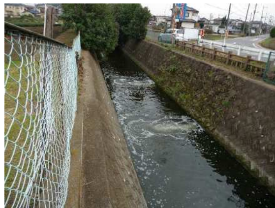
還流水が供給されている
