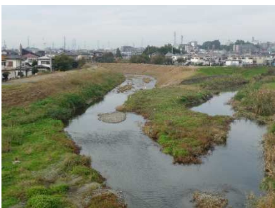
⑫新河岸川合流部
