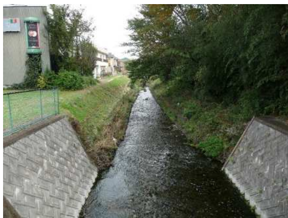
多自然型護岸に改修されている
