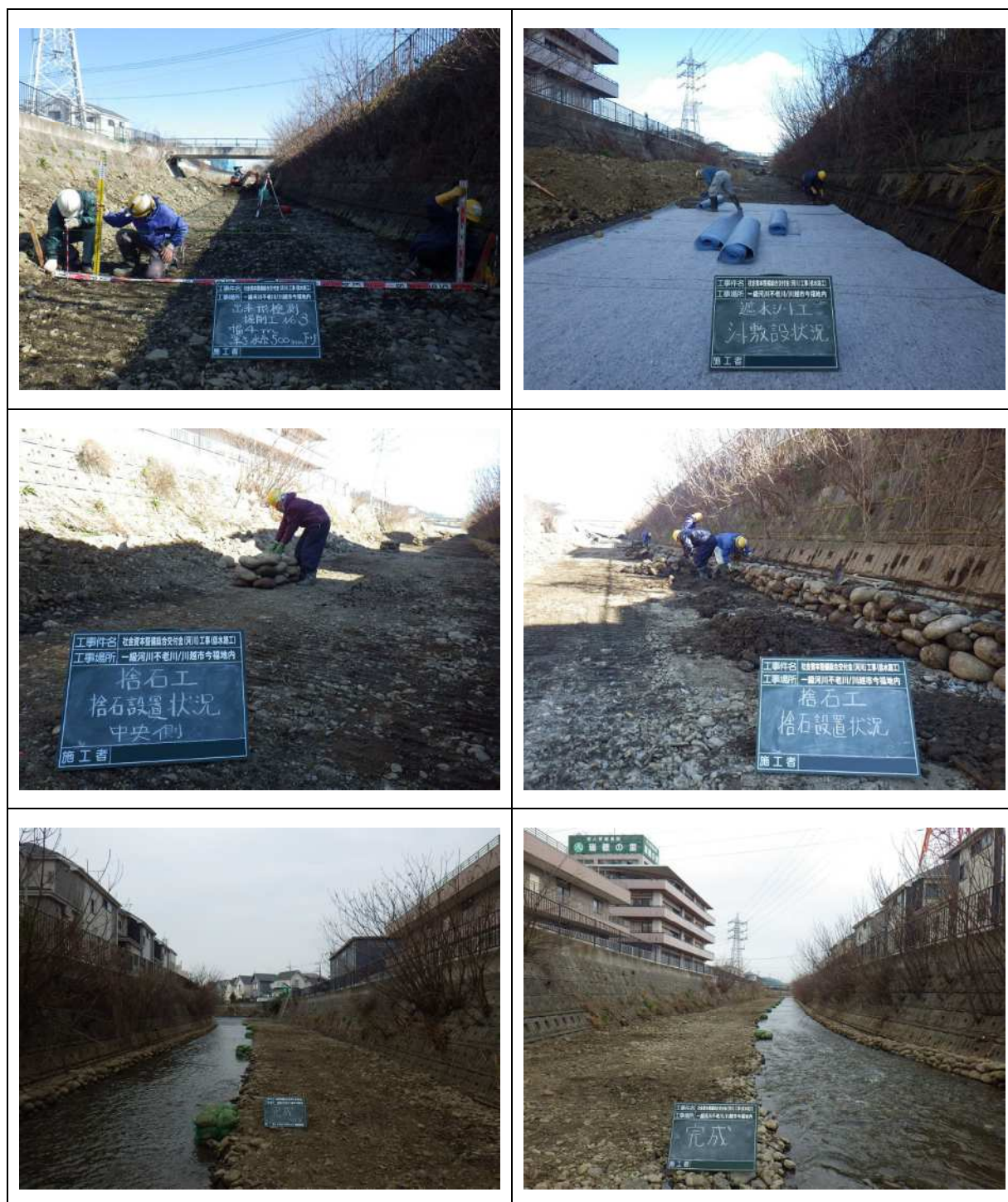
図 5.3 工事中および竣工時の状況
