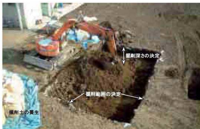
図 8-14 掘削除去の概況写真
