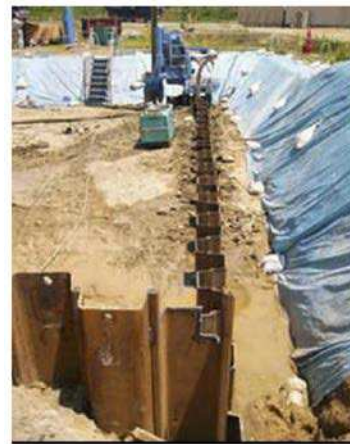
図 8-20 遮水壁（鋼矢板）の打設状況
