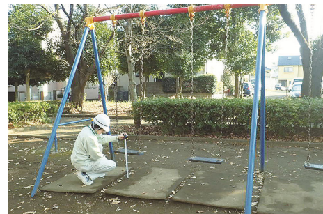
遊具の点検風景(亀ヶ谷公園)
