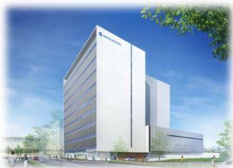
所沢駅東口駅前に建設された 日本光電工業(株)総合技術開発センター
