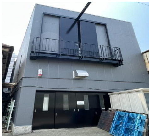
▲所沢本社工場
