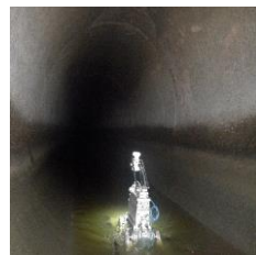
▲直径4mの管のカメラ調査
