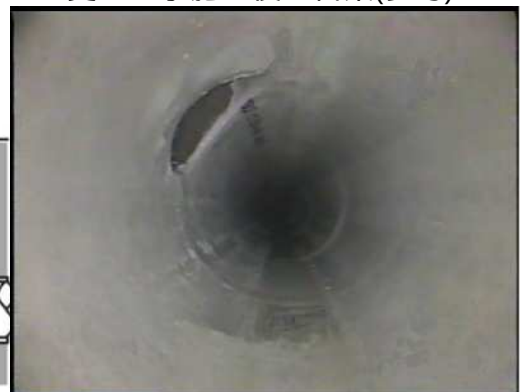
更生工事施工後の管渠(参考)
