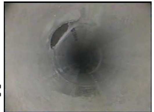
更生工事施工後の管渠(参考)
