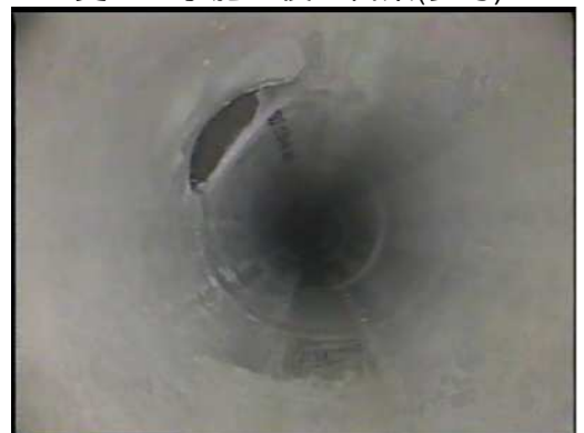
更生工事施工後の管渠(参考)
