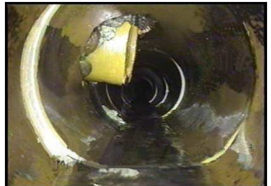
取付管が突出し老朽化した管渠(参考)
