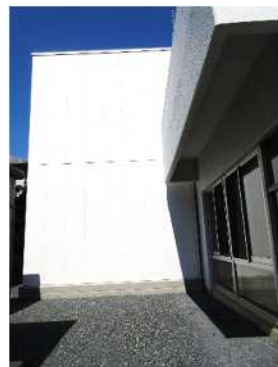
外から見るエレベーター棟
