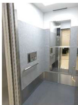
エレベーター内部
